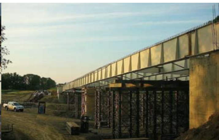
most přes Černý potok v km 3,720
