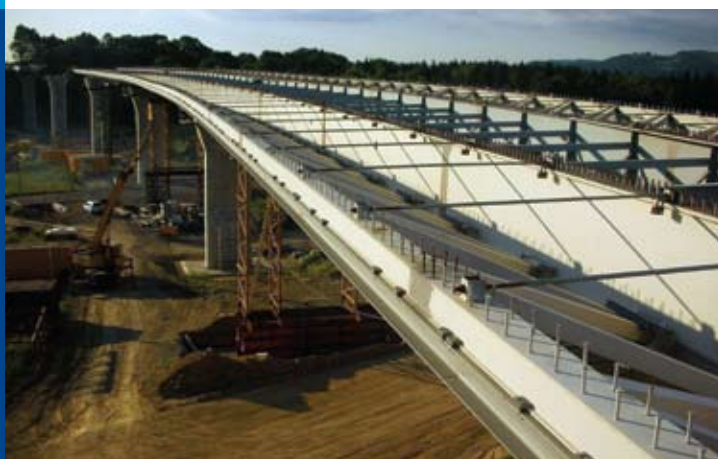
údolní estakáda v km 4,367–4,799, montáž ocelové konstrukce
