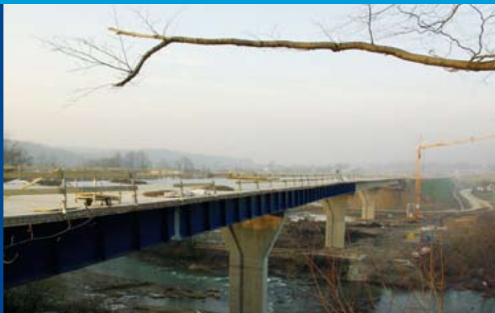
most přes Ošici v km 1,528 stavby
