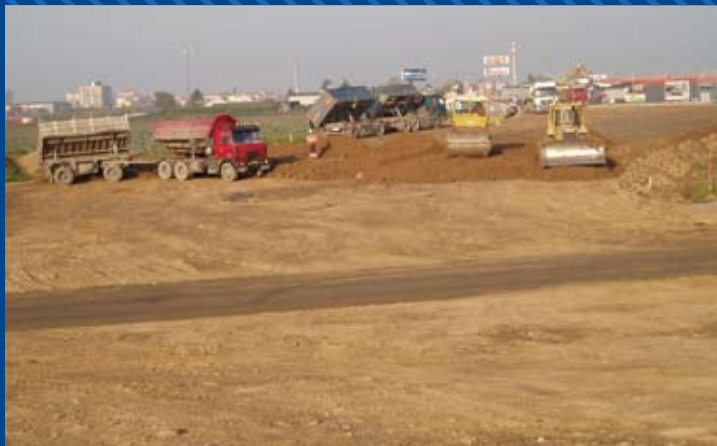
Okružní křižovatka Kateřinky – navážení zeminy do tělesa náspu – 9/2008
