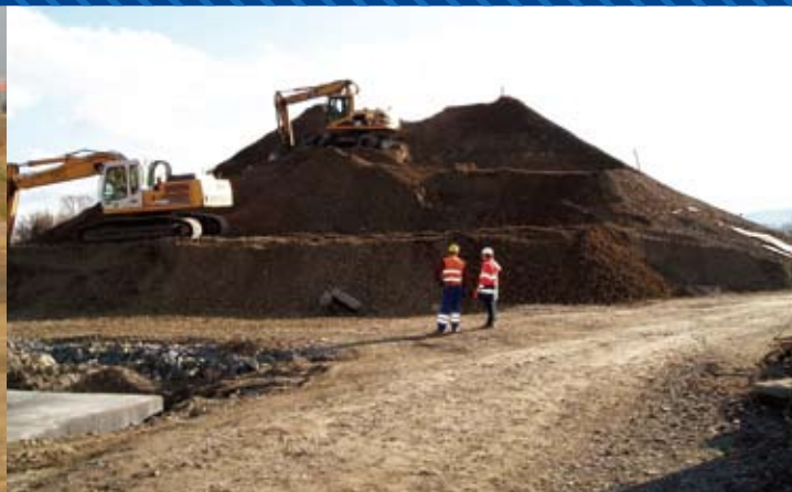
Odtěžování přítěžovacího nadnáspu nad opěrou estáky přes řeku Opavu – 12/2008
