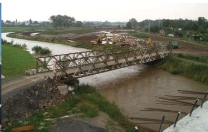
Mostní provizorium přes řeku Opavu – 2008–2009
