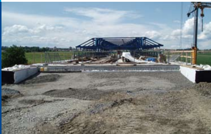
Estáková na spojení S1 přes řeku Opavu – pohled na betonářský vozík
