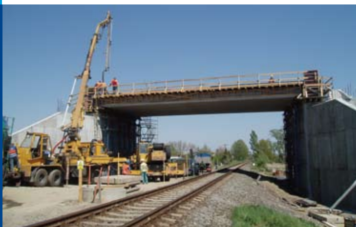
Betonáž mostovky mostu přes železniční trať – 5/2009
