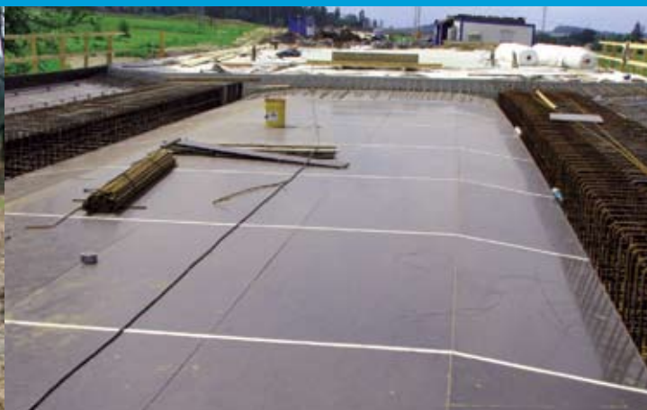
stavba bednění mostu přes železnici
