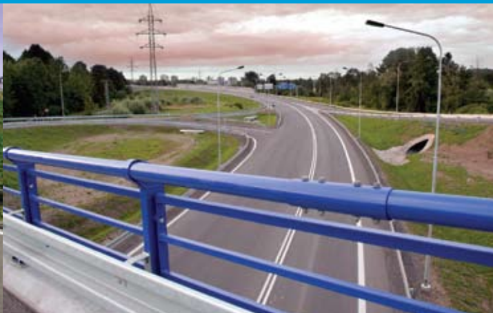
pohled na hlavní trasu silnice I/11
