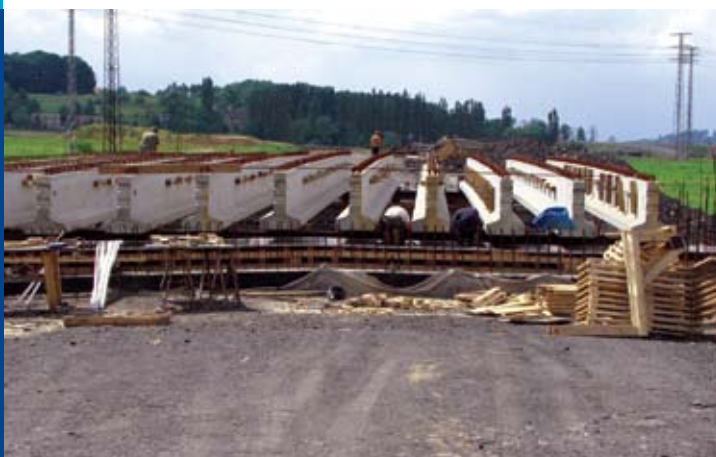
montáž prefabrikovaných nosníků
