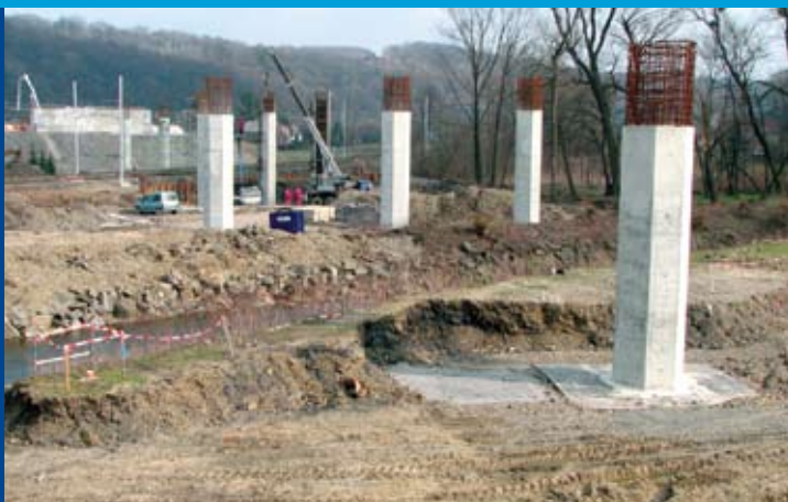
pilíře mostu přes železnici
