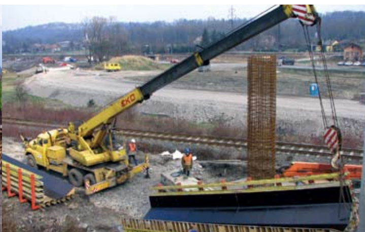
montáž bednění pilíře
