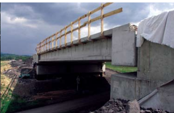
most z prefabrikovaných VST
