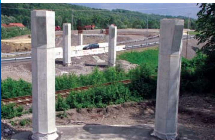
dokonné pilíře budoucího mostu
