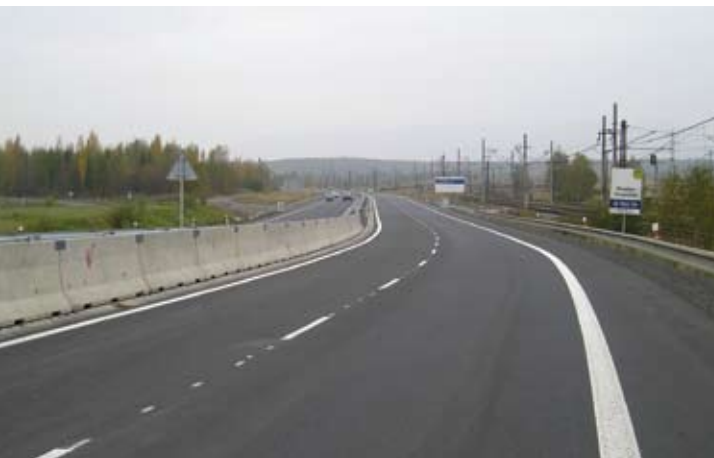
Konec úpravy silnice I/13
