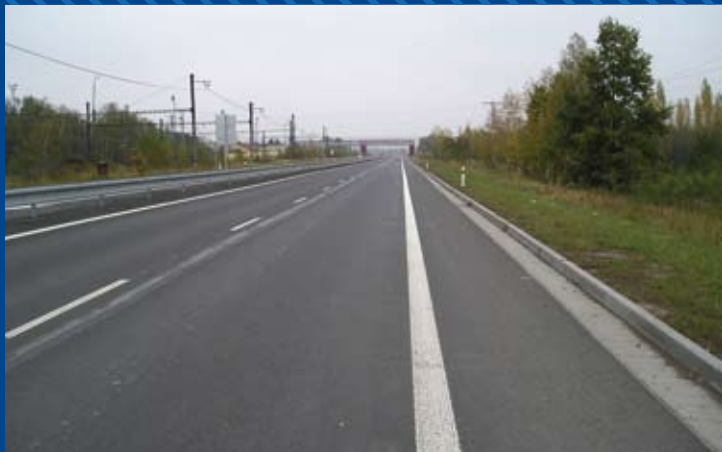
Začátek úpravy silnice I/13
