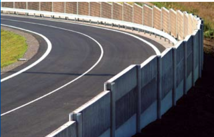
betonová protihluková stěna u zahrádkářské kolonie "U řáje"
