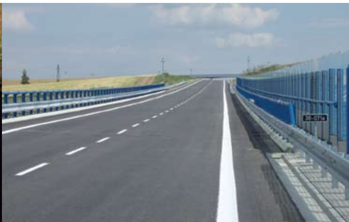
most přes údolí Pístoického potoka s protihlukovou stěnou
