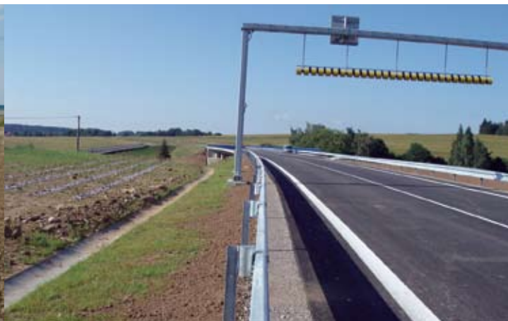
portál se zařízením na měření výšky vozidel v km 10,780
