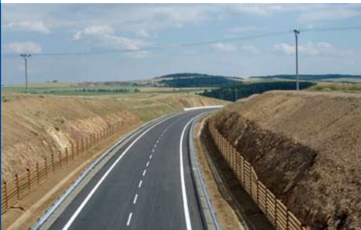
zábrana proti padajícímu kamení km 13,060–13,180
