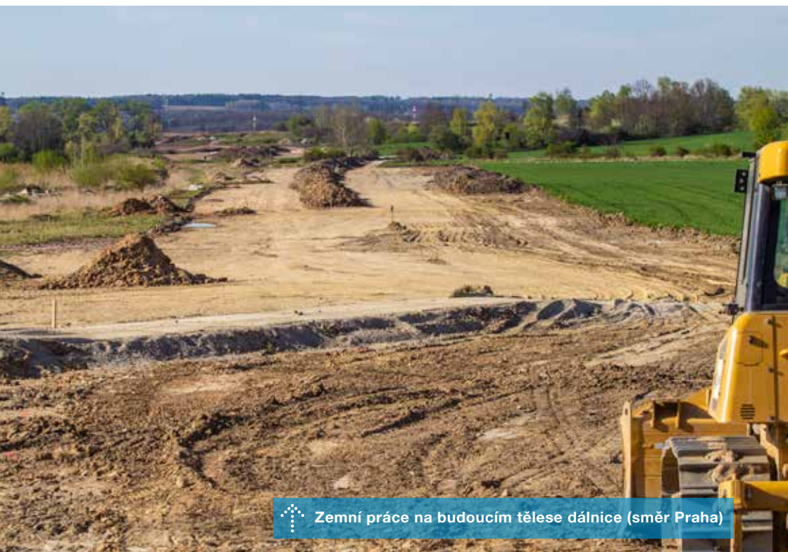
↑ Zemní práce na budoucím tělese dálnice (směr Linz)
